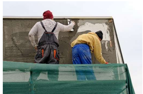
Abbildung 1: Verputzarbeiten an der Außenfassade
