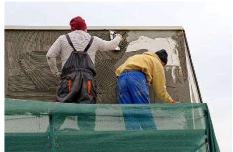
Abbildung 1: Verputzarbeiten an der Außenfassade
