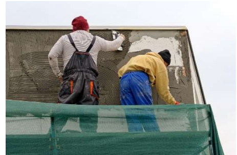
Abbildung 1: Verputzarbeiten an der Außenfassade
